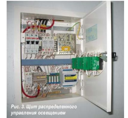
Рис. 3. Щит распределенного управления освещением
