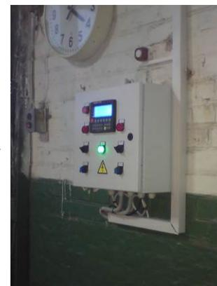
отображает мнемосхему АСУ, а также меню настроек, показания датчиков, состояния исполнительных механизмов и журнал регистрации событий. Так как использован свободнопрограммируемый контроллер, то стало возможным задействовать наиболее подходящие алгоритмы и учесть все пожелания заказчика. Даже те, о которых он и не подозревал, пока автоматчики не рассказали, что так можно сделать.
